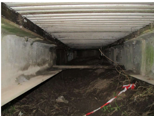
Kunstwerken: Hooibrug KW020 en Meulenbrug KW068 Het aanbrengen van een conservering op de stalen hoofddraagconstructie en het vervangen van de slijtlaag op het kunststof brugdek is voorzien in 2021. Globale kostenraming totaal € 35.000.
