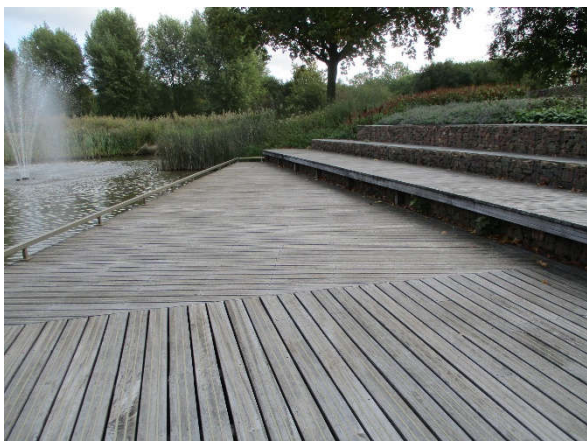
Kunstwerk: Retentievijver met vlanders KW067 In 2023 staat het vervangen van de slijtlaag (gripstrips) gepland. Globale kosten ruim € 40.000.
