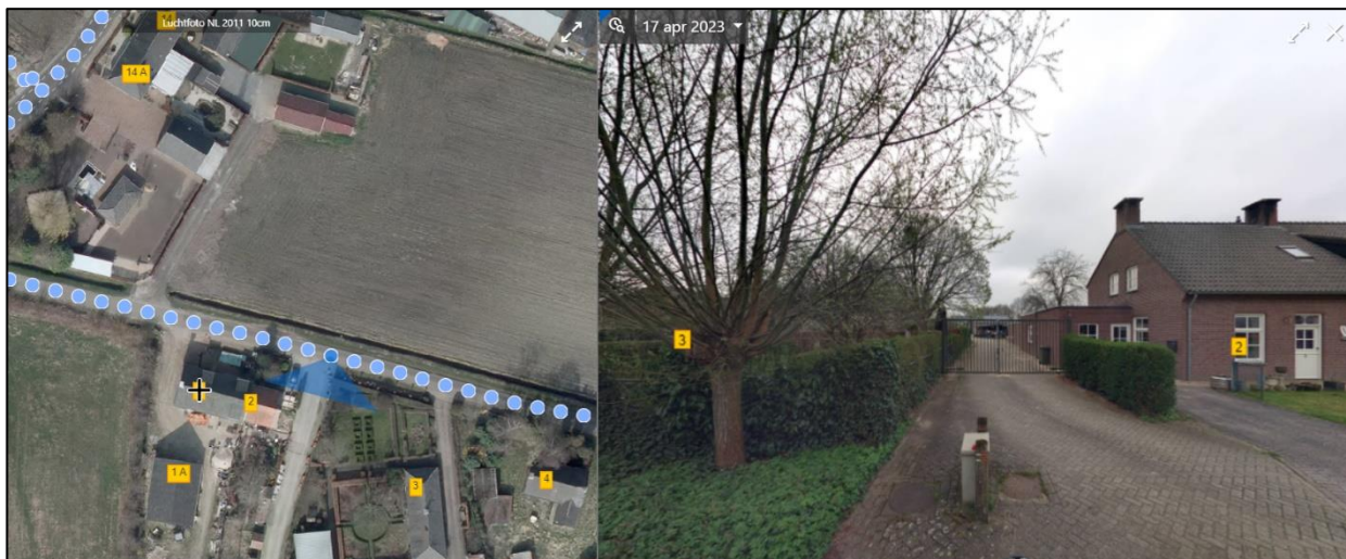
*Locatie te onttrekken deel van de Diepenbroek (bron: Streetsmart by Cyclomedia).
