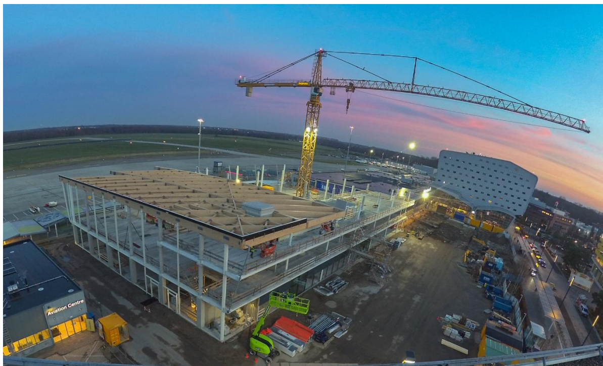
Figuur 4: Bouwwerkzaamheden voor de terminaluitbreiding.
