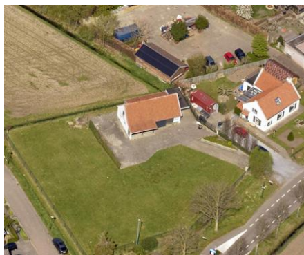
ZICHT OP WONING EN BIJGEBOUW AAN ZANDstraat 33 en 35
