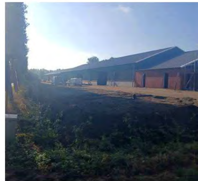
Figuur 6a: Huidig beeld de loods in aanbouw
