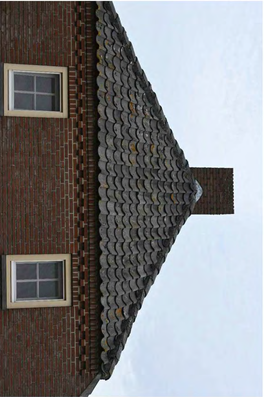
Top van de rechterzijgevel met siermetselwerk in de vorm van een overhoekse muizentand en bloktand onder het wolfeind.
