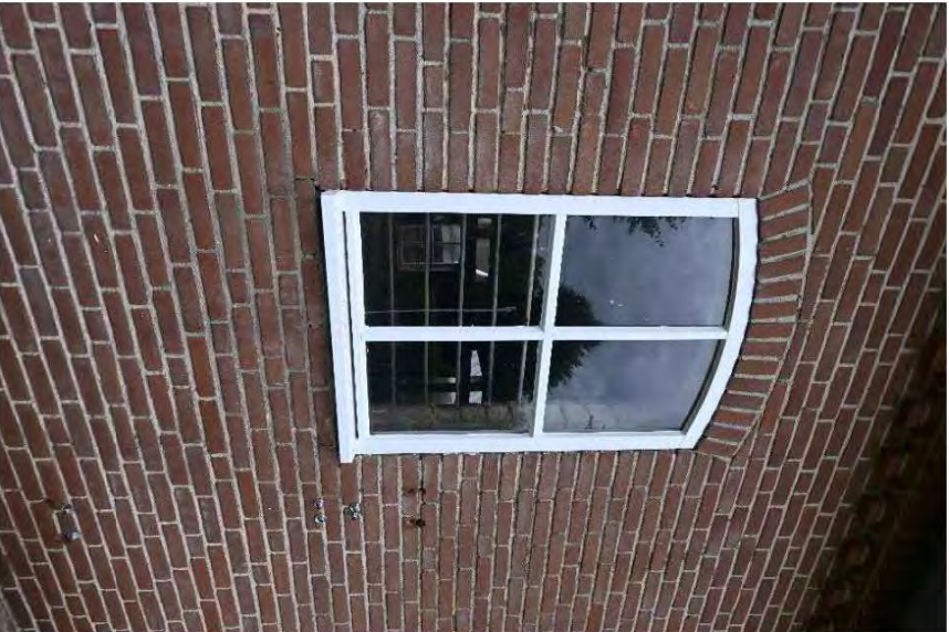
Getoogd vierruits stalvenster in de voorgevel.
