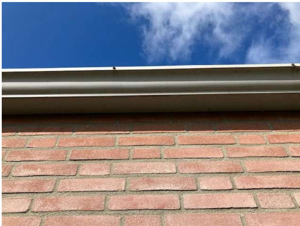
• Afbeelding 8: Detail onderzijde dakgoot, naadloos
