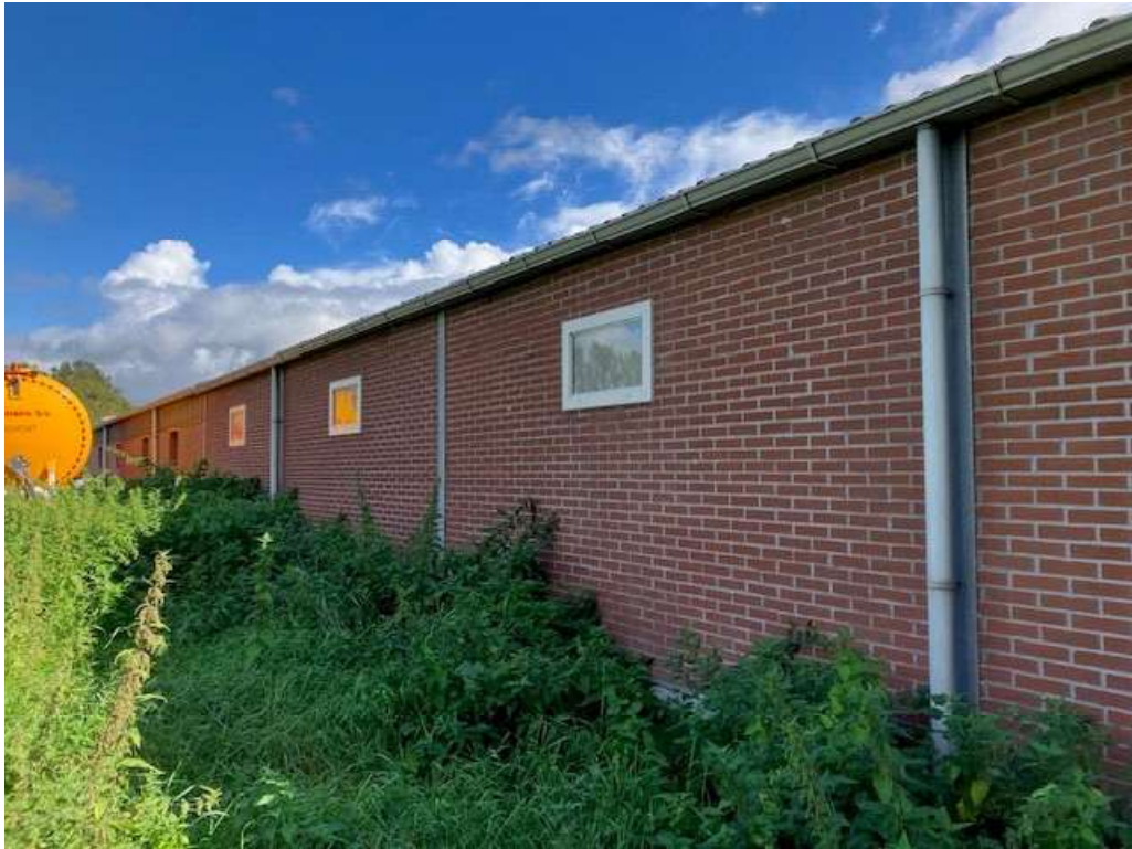
• Afbeelding 16: Gevel buitenste stal, bestaat uit prefab gevelelementen
