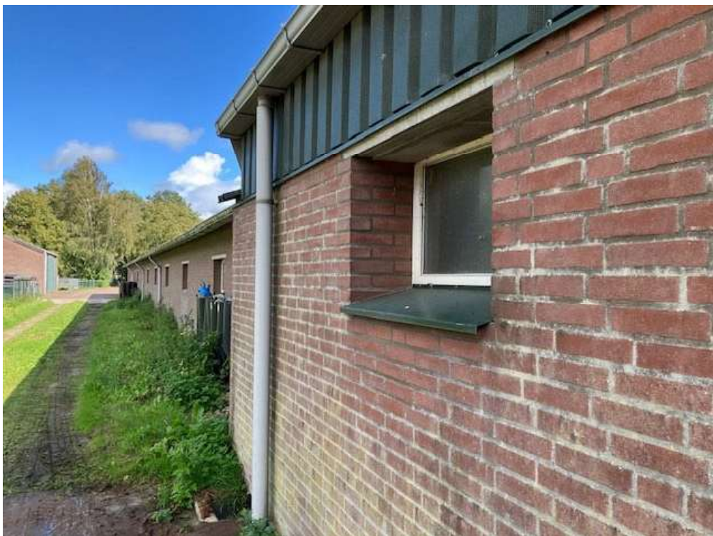
• Afbeelding 17: gevel te slopen varkensstal
