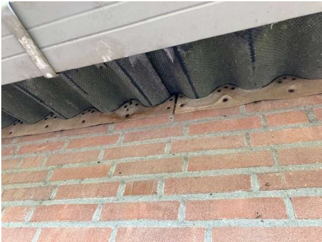
• Afbeelding 18: Onderzijde golfplaten dak, afgewerkt met vogelschroot
