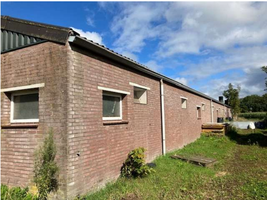
• Afbeelding 10: Zijgevel te slopen stal
