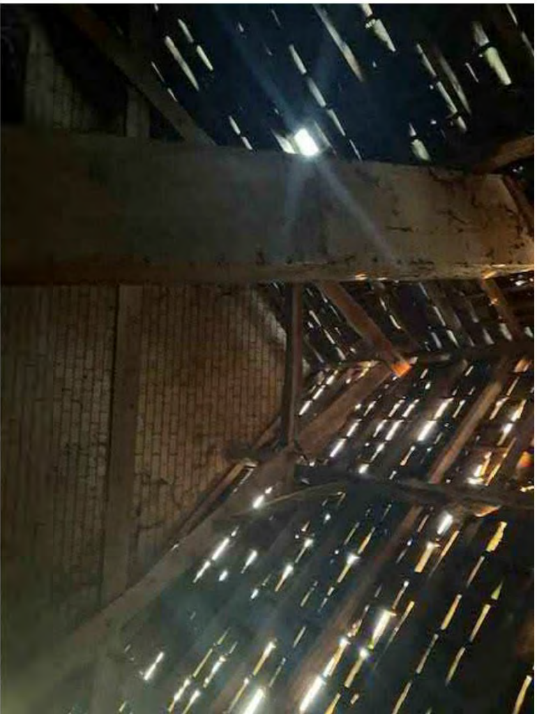
• Afbeelding 8: onderzijde van het dak van het achterhuis, dakpannen zonder dakbeschot
