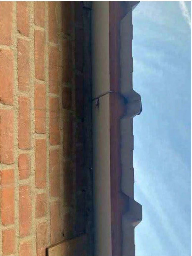
• Afbeelding 18: onderzijde ecopanelen op een houten randbalk
