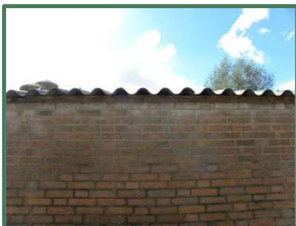
Muurplaat op het dak
