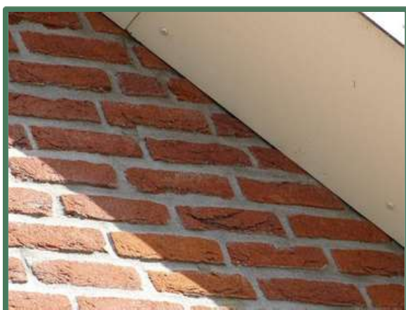
Trespa boeiboord strak aangesloten op de muur
